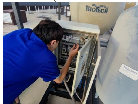
ตรวจเช็คถังเก็บน้ำสำรอง/ระบบสูบน้ำ
